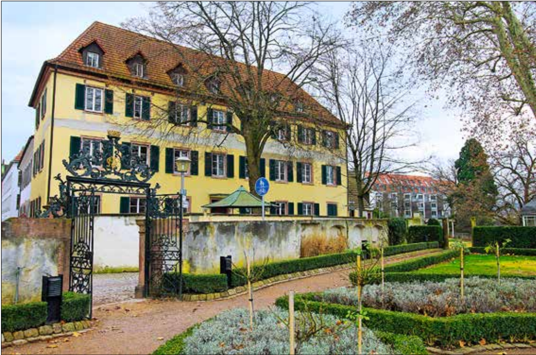
Blick aus dem Vinzentiusgarten. Sanierung an markanter Stelle.
