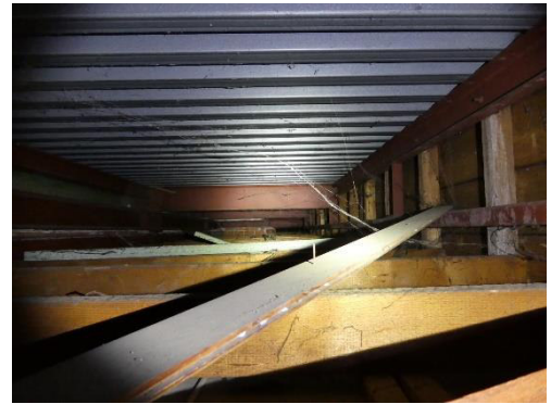
Abbildung 8: Dachstuhlbereich von innen (05.10.2023)
