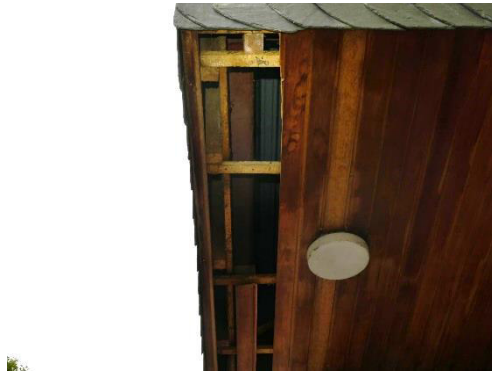
Abbildung 7: Blick von unten auf Dachstuhlbereich (05.10.2023)
