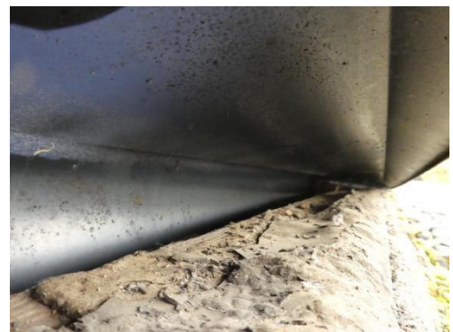
Abbildung 10: Angehobenes Atikablech (05.10.2023)
