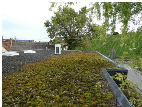
Abbildung 9: Dachbereich von oben (05.10.2023)
