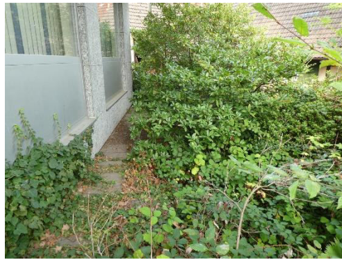
Abbildung 5: Nördlicher Bereich des Abzureißenden Gebäudes mit Blick nach Westen (30.08.2023)
