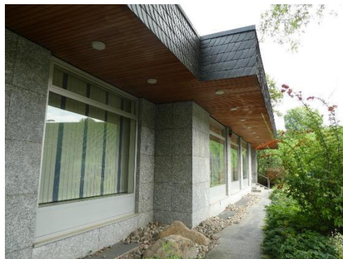
Abbildung 4: Abzureißendes Gebäude mit Blick nach Norden (30.08.2023)
