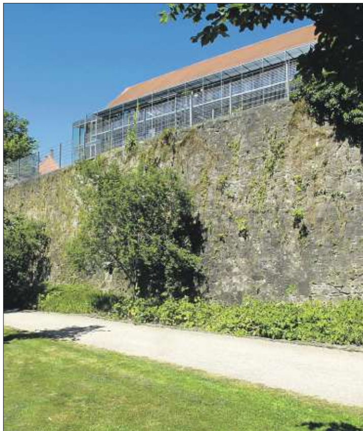
Südlich des Vinzentiusgartens. Hier soll der Aufzug hin. Foto: Reinbold
